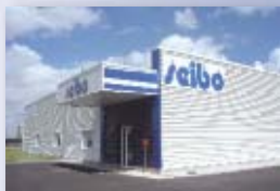
Le centre de proximité SEIBO du Parc des autoroutes couvre 400 m 2 d'ateliers
